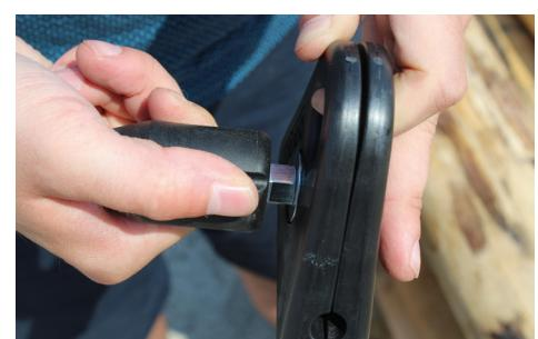
Alle hoek- en zijklemmen zijn standaard ontwikkeld om te worden gebruikt voor zowel aluminium palen als houten palen. Voor gebruik bij houten palen schroef je het plastic stuk los. Hierin zit een langwerpige moer die je opnieuw vastdraait. Deze past precies in het gat van 16 mm dat werd voorgeboord. Aanspannen gebeurt met het plastic stuk waar de lange moer in zat.
