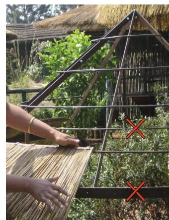
**Schritt 5:** Setzen Sie den Dachkegel außen auf den Rahmenfirst, gegebenenfalls mit einem Besenstiel. Bei großen Durchmessern können Sie den Dachkegel zunächst auf den Rahmen setzen und dann anheben, um die letzten Reetpaneele festzuklemmen. Um den Kegel an Ort und Stelle zu halten, befestigen Sie ihn mit den hierfür vorgesehenen Seilen auf dem Rahmen.
