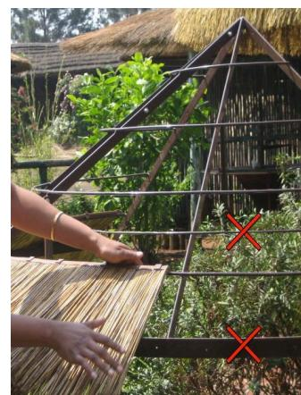
**Stap 5:** Plaats de dakkegel langs buiten op de nok van het frame, eventueel met behulp van een bezemsteel. Bij grote diameters kun je de dakkegel eerst op het frame plaatsen en hem optillen om de laatste rietpanelen vast te klemmen. Om de kegel op zijn plaats te houden bevestig je hem op het frame met de touwen die hiervoor dienen.
