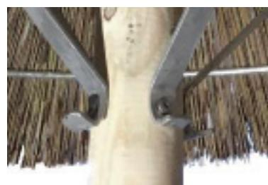
**Stap 4:** Klem de rietpanelen met de daaraan bevestigde haakjes langs buiten op de metalen cirkels: begin met de tweede rij vanaf de onderkant van de helling. De onderste ring dienst als steun om het riet op te laten rusten. Tip: leg de dikste riet- of makutipanelen opzij voor de hoogste rij.
