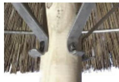
**Schritt 4:** Klemmen Sie die Reetpaneele mit den daran befestigten Hähkchen von außen an den Metallringen fest: Beginnen Sie mit der zweiten Reihe von der Unterseite der Schrägen gesehen. Der unterste Ring dient als Stütze, auf der das Reet aufliegt. Tipp: Legen Sie die dicksten Reet- oder Makuti-Paneele für die höchste Reihe beiseite.
